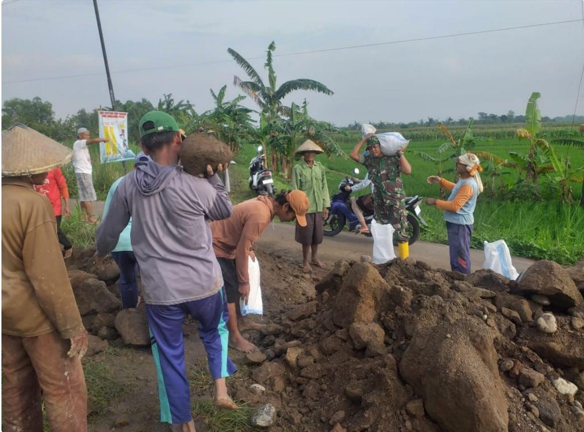
Babinsa Serda harmono menyampaikan perbaikan tanggul dengan cara memancang Bambu dan memasukkan tanah ke dalam karung untuk kemudian di tumpuk di bagian tanggul sungai yang Jebol sepanjang kurang lebih 3 Meter, lebar 2 Meter dan kedalaman 3 meter. “Dengan penataan tanggul menggunakan tanah yang di karungi seperti yang kita lakukan saat ini, maka tanah tidak akan mudah longsor ketika turun hujan”, imbuhnya.
