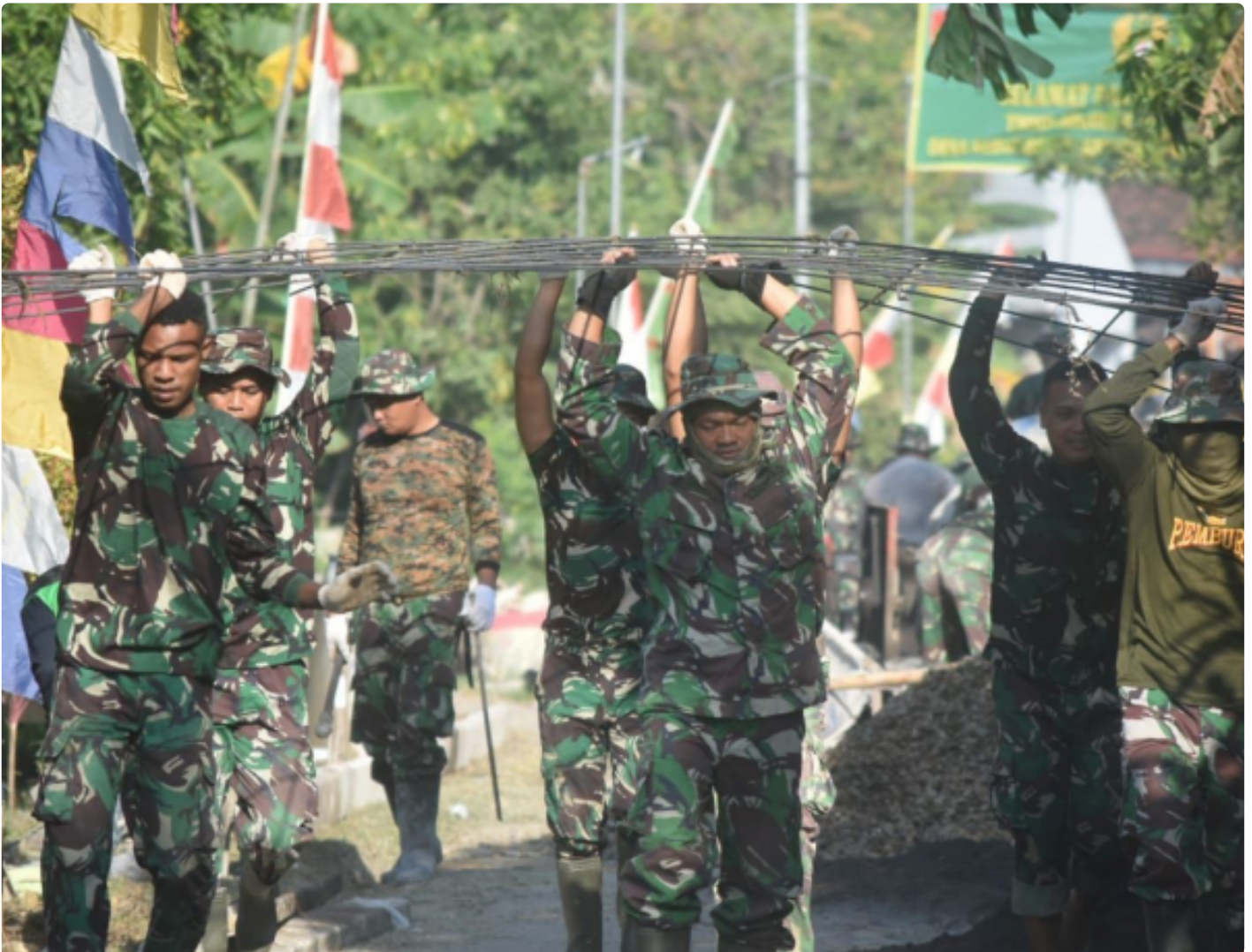
TMMMD Reguler ke-114 Kodim 0716/Demak Sasaran Pengecoran Jalan Desa Kebonagung, Demak.
