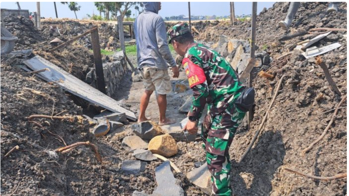
Bersama Warga, Babinsa Gotong Royong Bangun Talud Irigasi.
