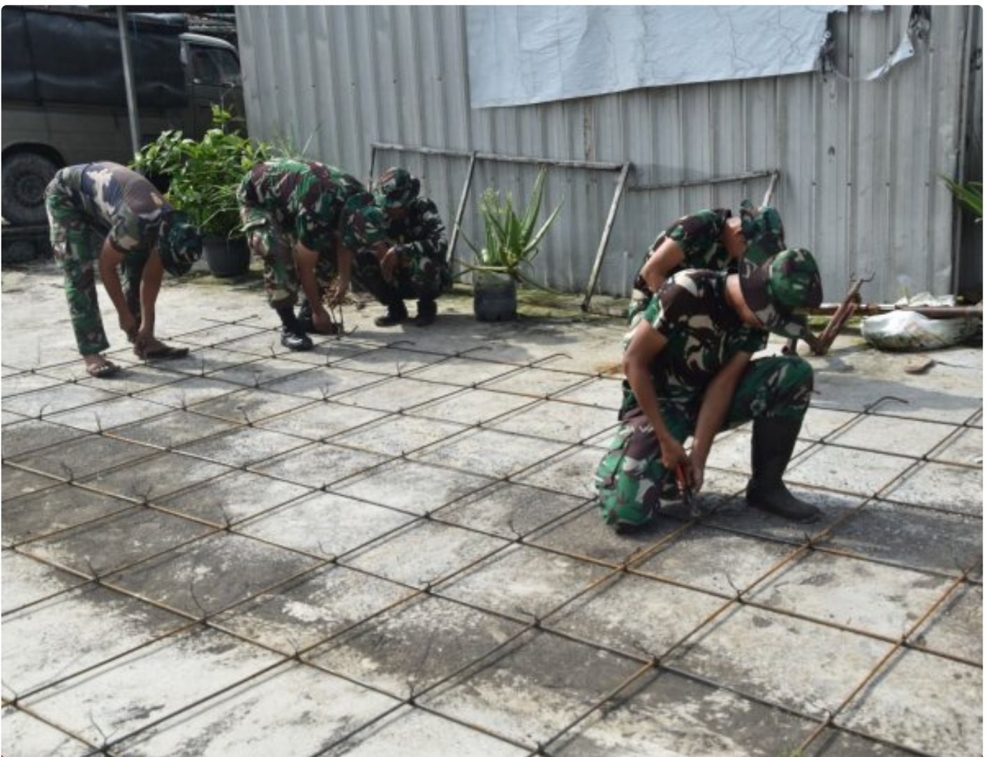
anggota satgas TMMD rakit besi untuk pengecoran jalan
