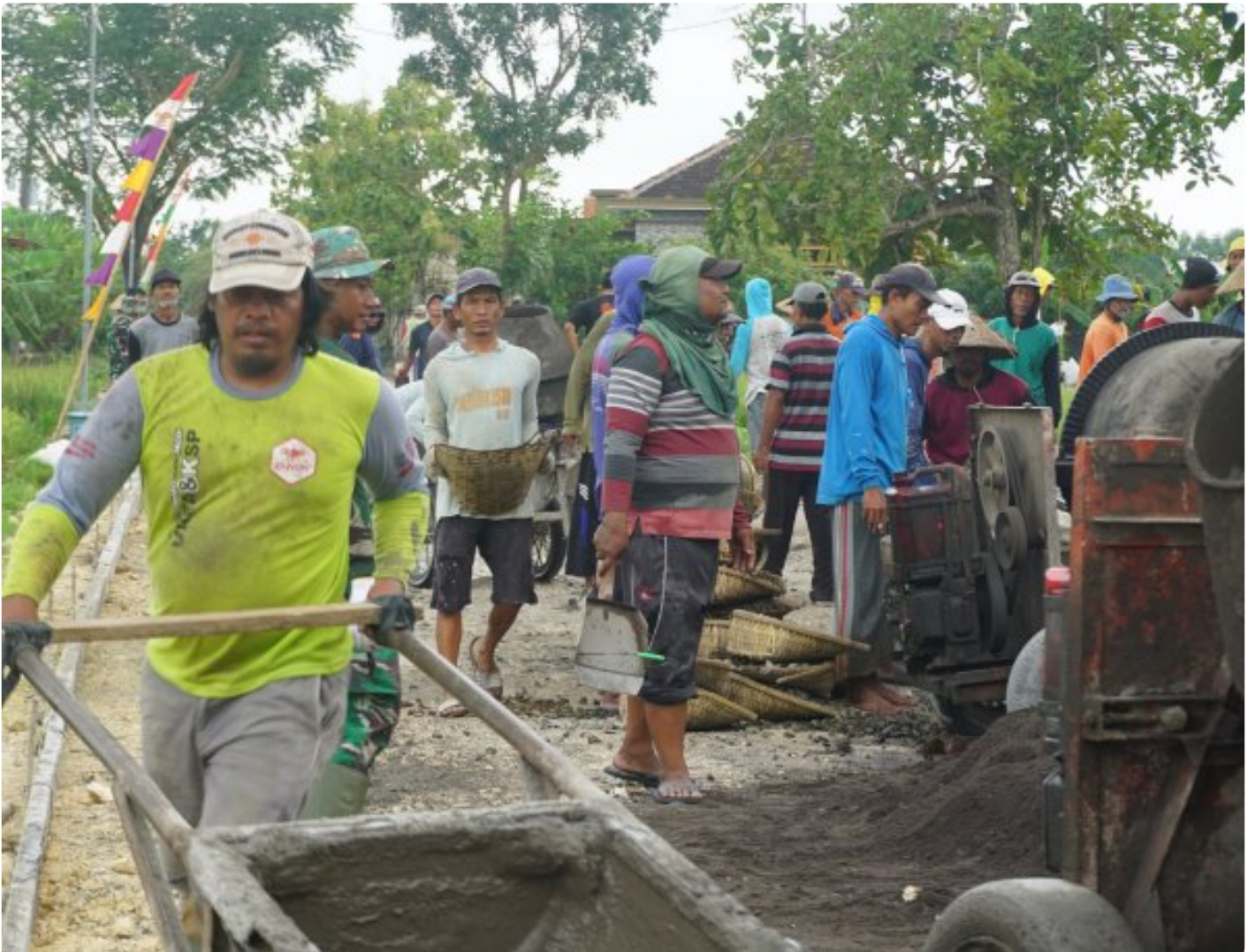
Warga Desa Bandungrejo, Karanganyar, Demak, Berbondong-bondong Bantu Dalam Pengecoran Jalan TMMD
